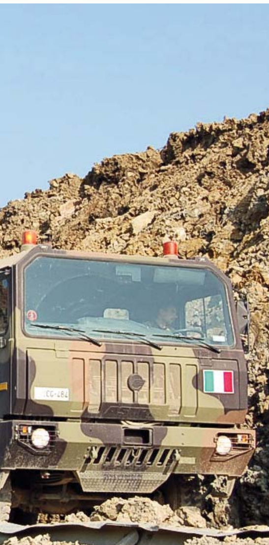
Rimozione di materiale franoso.
