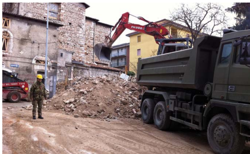
Rimozione di macerie a seguito del terremoto in Abruzzo.
